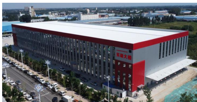
图 46 实训中心实拍俯视图
