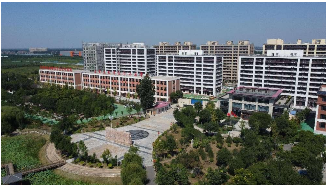
图 2 石家庄城市经济职业学院东校区实拍俯视图
